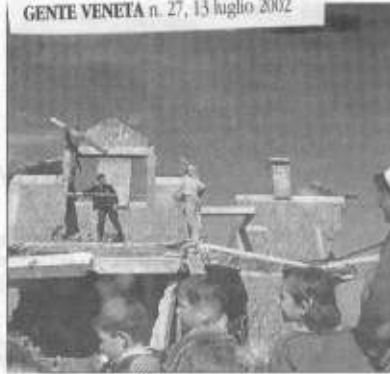
Bambini assistono ai lavori di ricostruzione di una casa in Kosovo.
