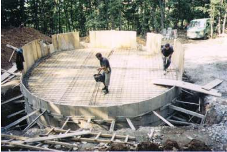
lavori di distribuzione dell'acqua
